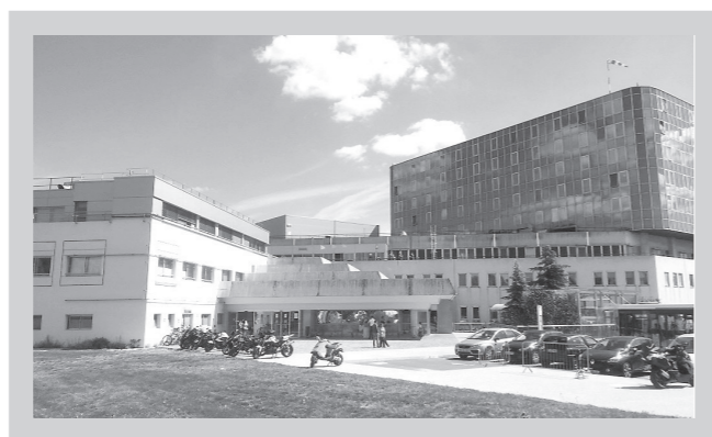
●写真2 André Mignot Hospitalの外観
