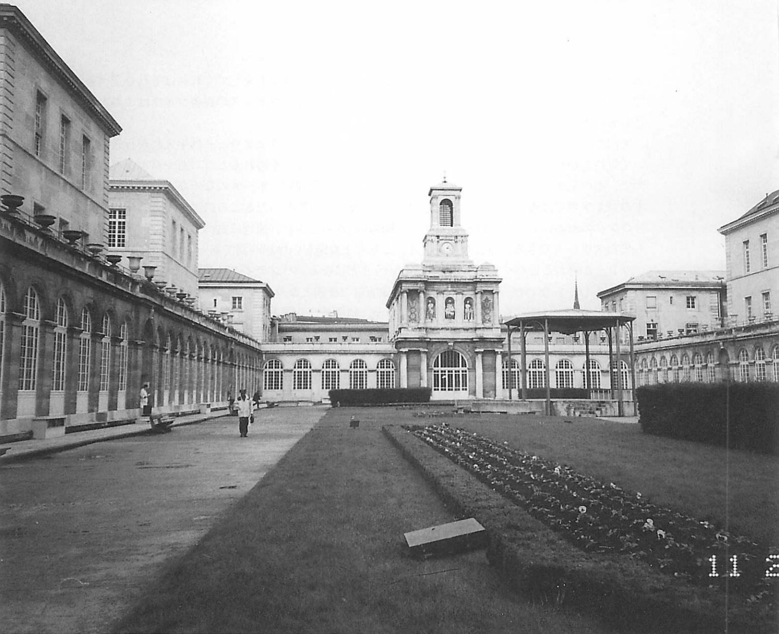
▲三重大学山川先生が研修されたラリボアジエール病院。1830年創立当時の外観を保っています。 もともと3階建ての建物ですが、中身は近代的で実際は地上6階地下2階になっています。手術室は地下にあり整形専用です。正面は附属の教会です。
